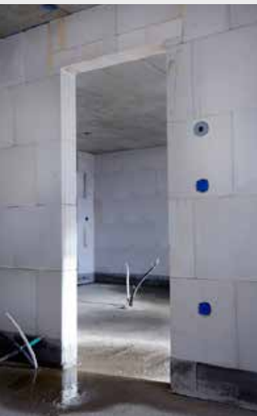
▲ Unversehrte KS-QUADRO E Wände mit intelligentem Innenleben.
