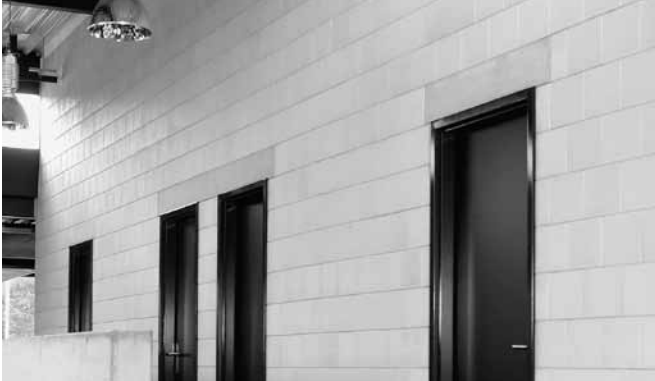
oben: verblendeter Sturz unten: gefaste Sichtbetonstürze
