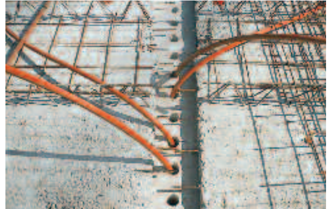
DIE INSTALLATIONSKANÄLE DER WÄNDE SIND VON DER DECKE AUS SICHTBAR. HIER ERFOLGT DIE LEERROHRINSTALLATION.
