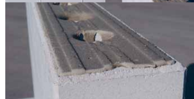
Rasches und regelmässiges Auftragen des Dünnbettmörtels mit dem Mörtelschlitten.
